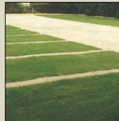
Places de stationnement drainantes et végétalisées, évitant l'utilisation d'enrobé tout en restant tout à fait praticable en périodes de pluies
